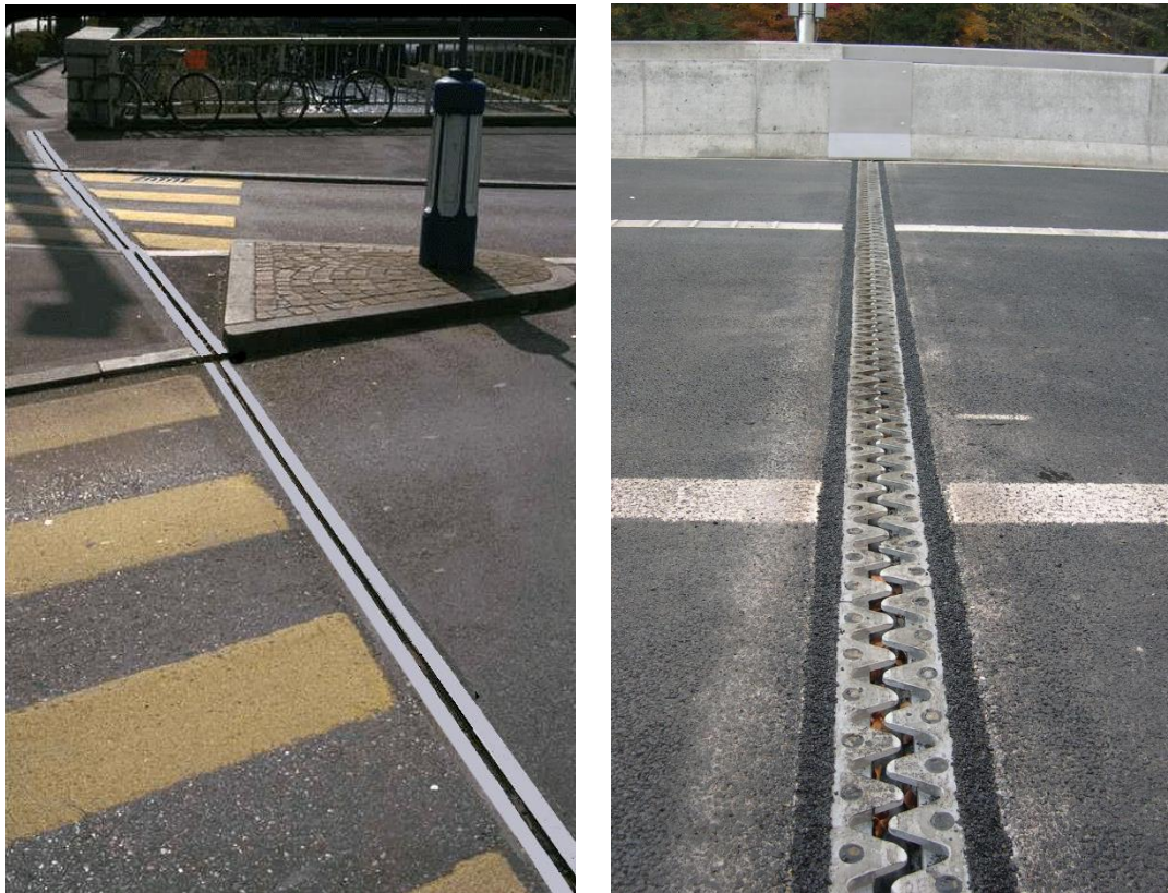
Fig. 3.3 Joints de chaussée à profilé compressible (à gauche, sans plaques sinusoïdales; à droite, avec plaques sinusoïdales).
