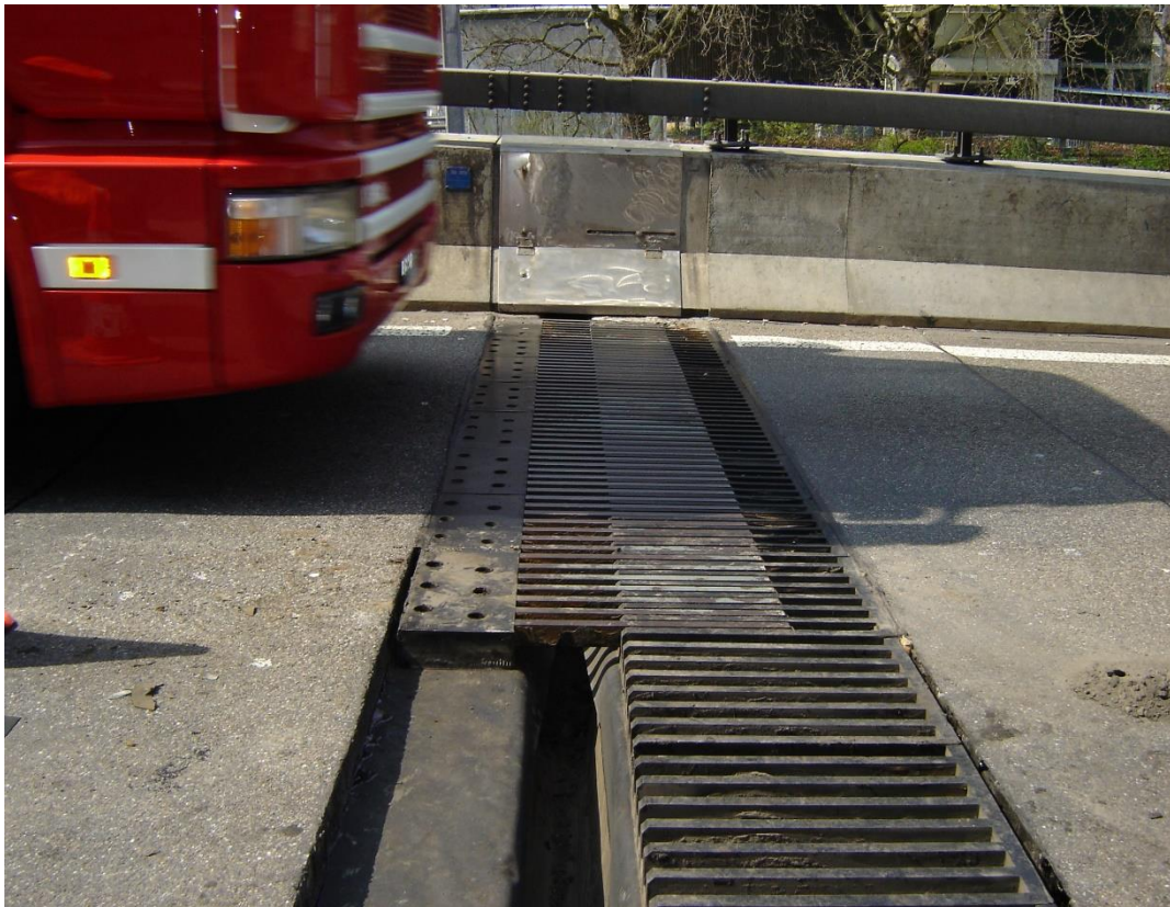
Fig. 5.4 Eléments d'un joint de chaussée à peigne appuyé (photo de montage).
