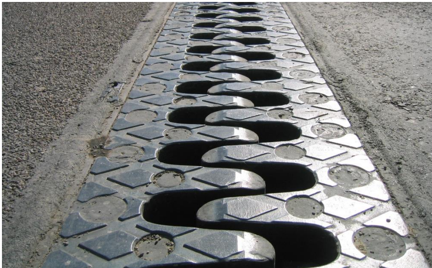
Fig. 4.3 Joint à peigne avec fraisages en losange.
