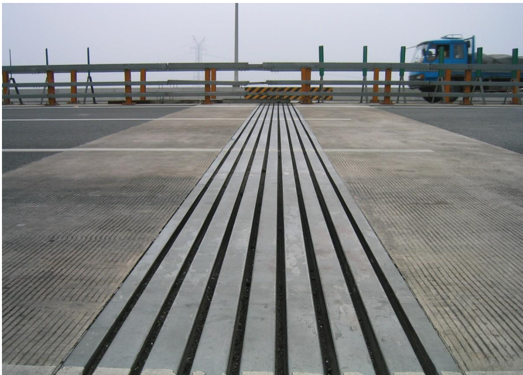
Fig. 6.3 Joint de chaussée à huit profilés compressibles (6ème Qian Tang Bridge, Chine).
