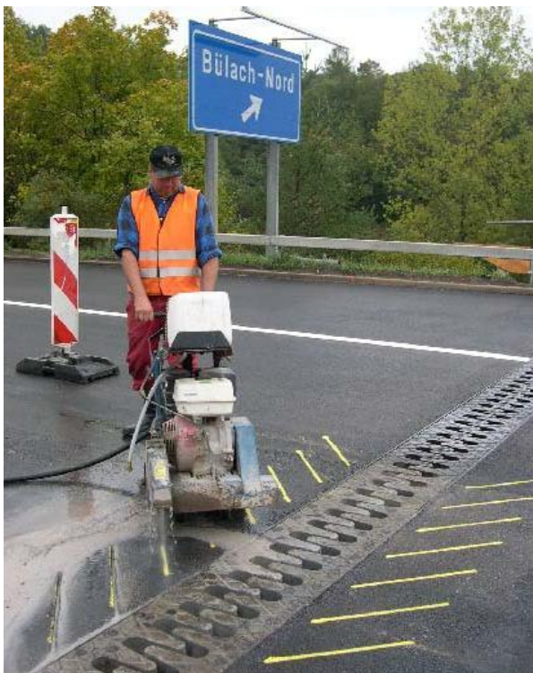
Fig. 4.4 Fraisage de nervures d'appui sur un joint à peigne en console.
